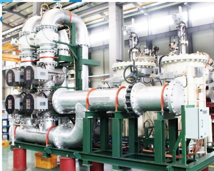
GloEn-Patrol™ представляет собой комбинированную систему очистки балластных вод (СОБВ), сочетающую преимущества механической фильтрации и УФ-излучения. Данная система обеспечивает наиболее экологически благоприятное и оптимально спроектированное решение для установки и эксплуатации на судах любого типа.
